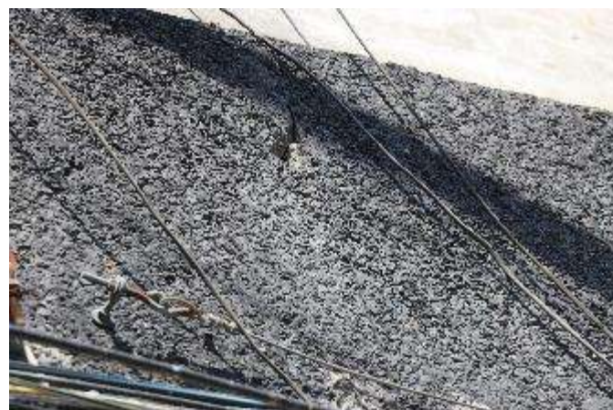
הדגשה אופקית בגרנוליט שחורה, מבט מקרוב.
