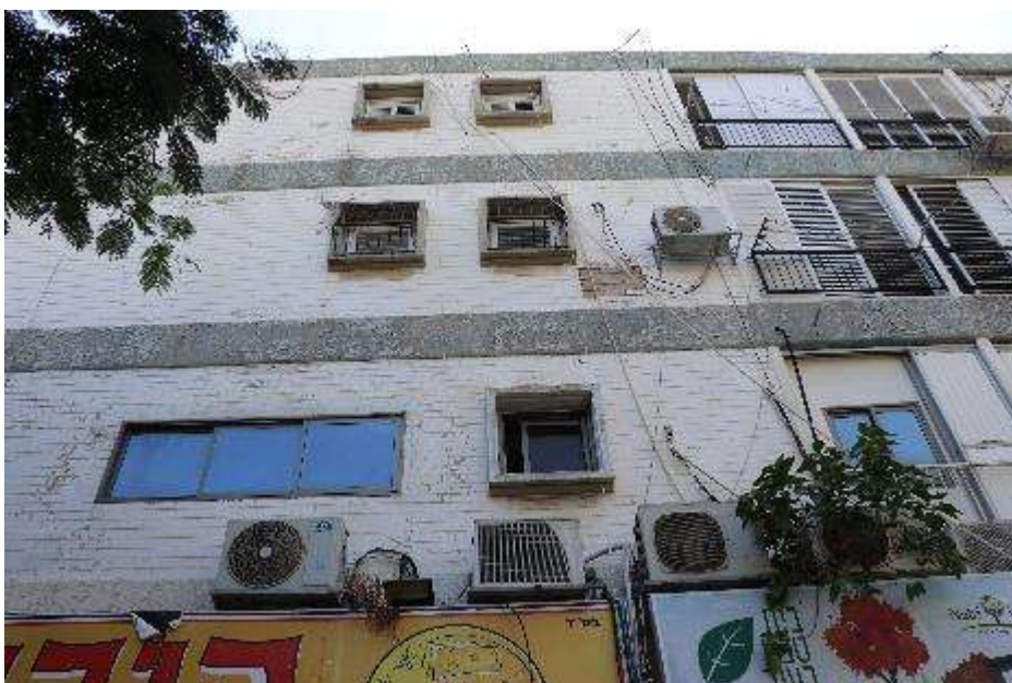
פרט מקטע חזית בלבני סיליקט עם חלונות חדרי שינה. מימין מרפסות חדר מגורים, במקור פתוחות מרצפה עד תקרה.
