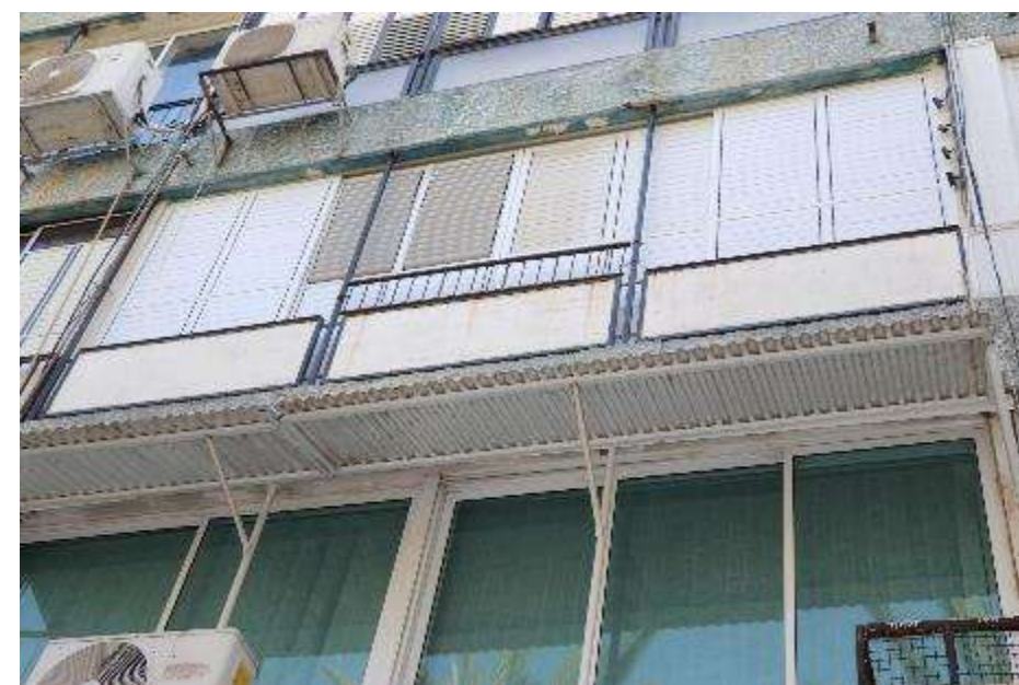
הדגשות אופקיות בחזית ראשית, מעקה ברזל, ועיגוני מעקה ברזל בעמוד בחתך עגול מרצפה לתקרה במרחקים קבועים, בחזית ראשית מערבית.
